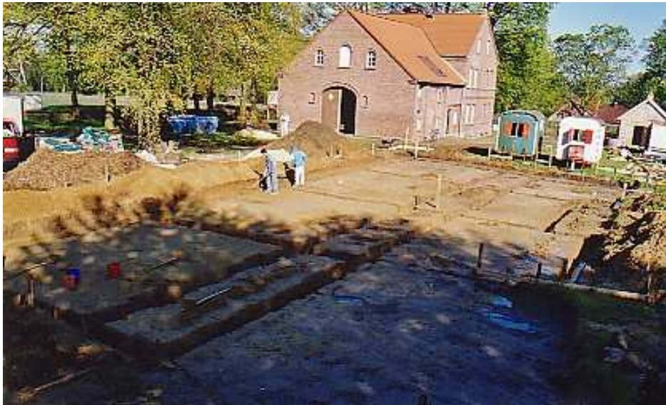
Durch die gezogenen Fundamentgräben ist die spätere Nutzung der Scheune, das Produktenhaus, abzulesen.
