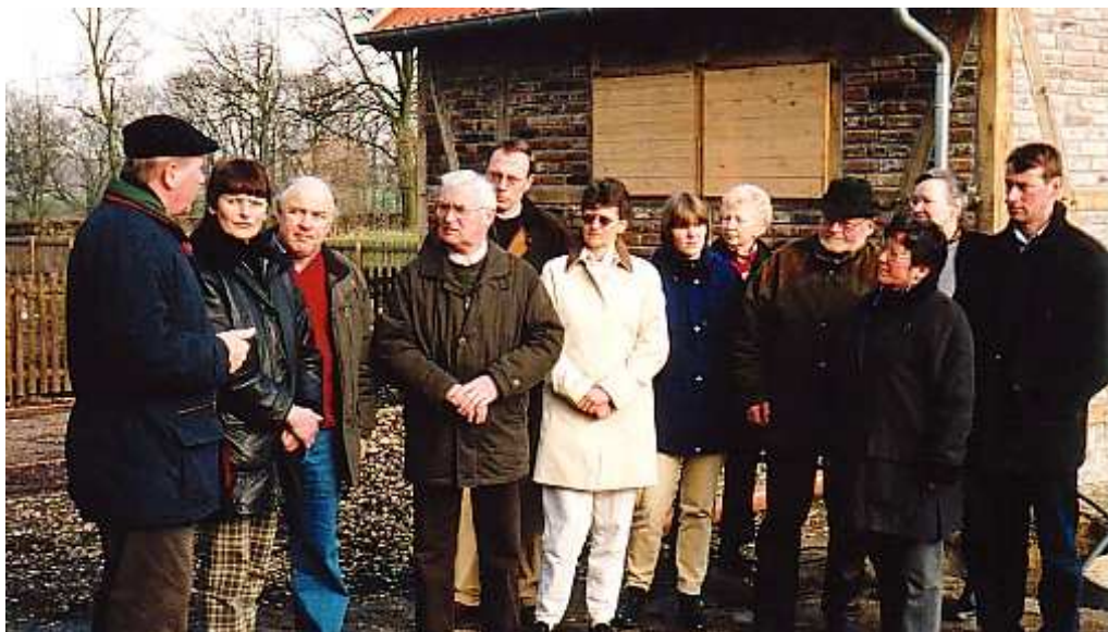
Die Nachbarn sind zu Besuch, um die Fortschritte der Bauarbeiten zu begutachten.
