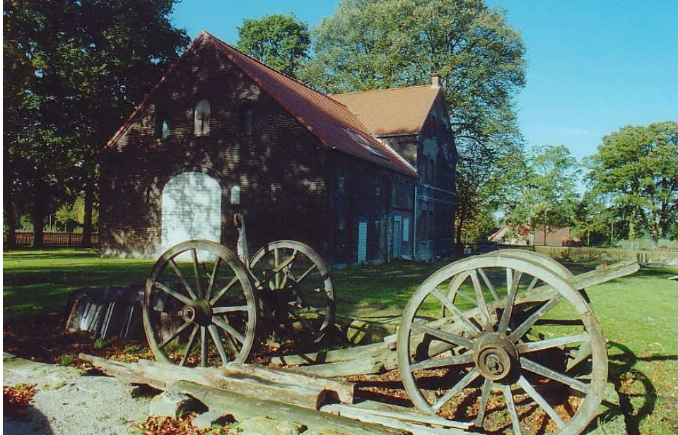
Wenn die Sonne darauf scheint, wirken die immer noch zugemauerten Fenster und Türen nicht mehr so abweisend
