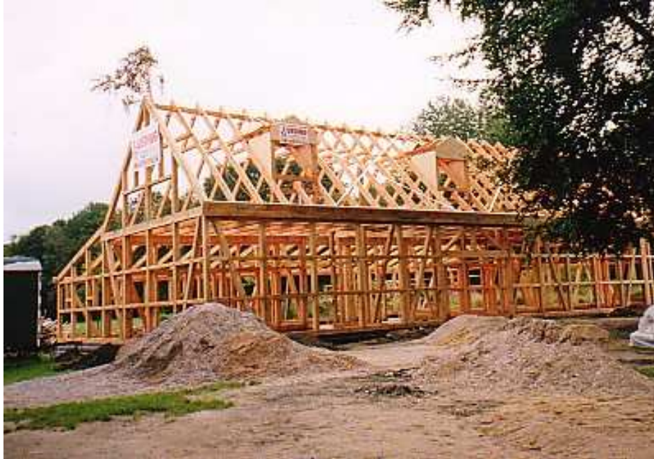
Das dritte Richtfest nach dem Backhaus und dem Haupthaus
