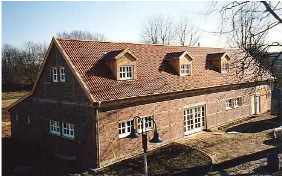
Wenige Wochen später ist das Produktenhaus in seiner äußeren Gestalt fertig.
