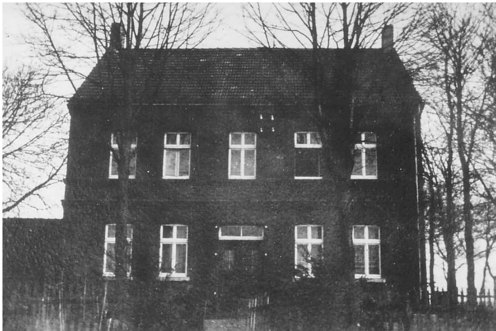
Ein altes Foto des Hofes von 1960. Nach dem Tode des 1996 verstorbenen Bauern stand der Hof leer und verfiel mehr und mehr.
