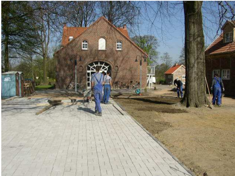
Im März 2003 ging es mit Hochdruck an die Außenanlagen, hier ein Teil des späteren Parkplatzes
