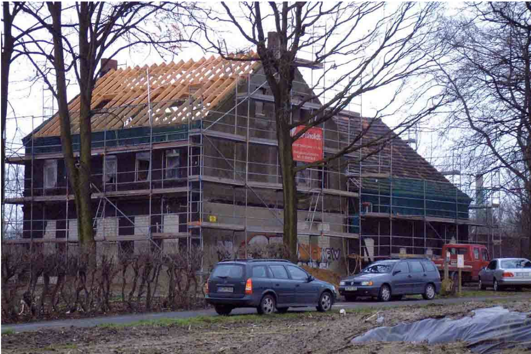
Februar 2001, ein neuer Dachstuhl wird montiert – die Stiftung ist stolz auf ihren ersten großen Erfolg.
