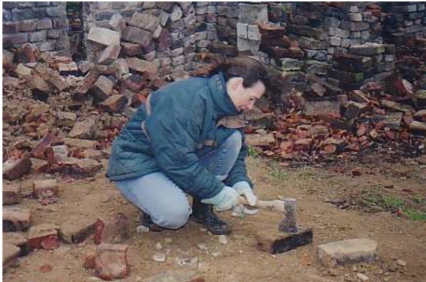
Alte Steine sauber abgepickt und für das Backhaus gestapelt.
