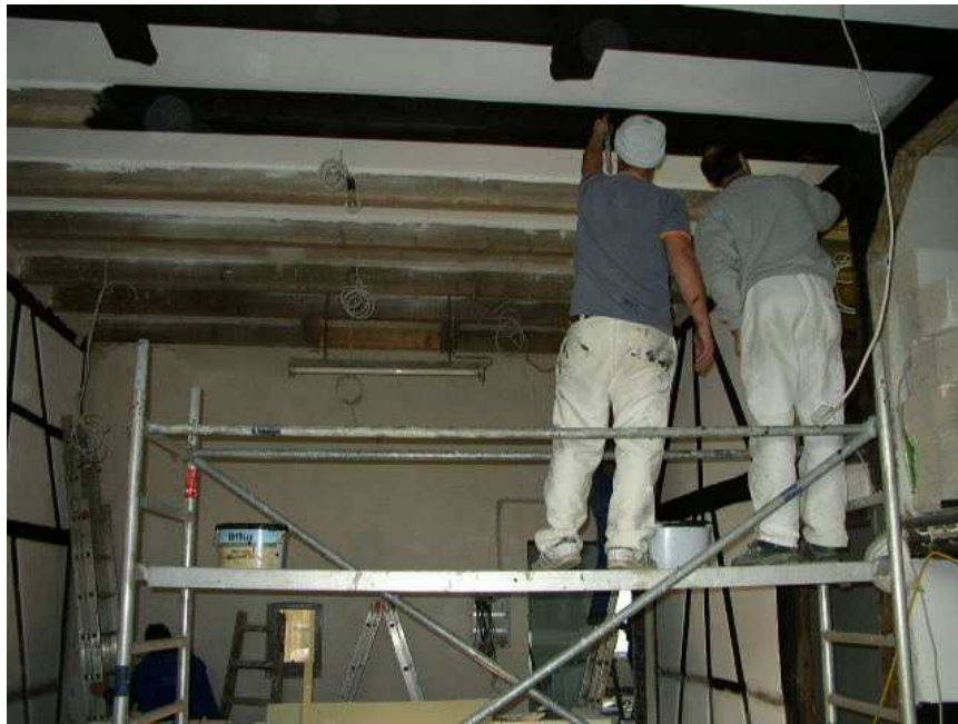
Jugendliche streichen die Balken der Tennendecke und weißen die Zwischenflächen.
