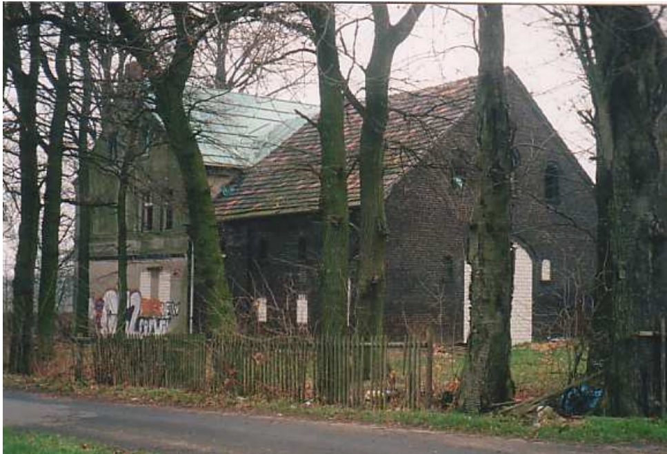
„Katzenhaus“, wie die Kinder der Umgebung das zerfallende Haus nannten, im Dezember 1999, kurz vor dem Kauf.
